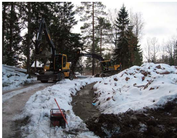
Arbetet med nya VA-ledningar längs Vänerkusten pågår.
