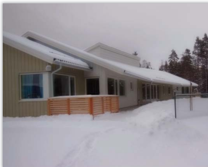
Samhällsbyggnadsnämnden har byggt ett nytt LSS-boende på Bladvägen 2.
