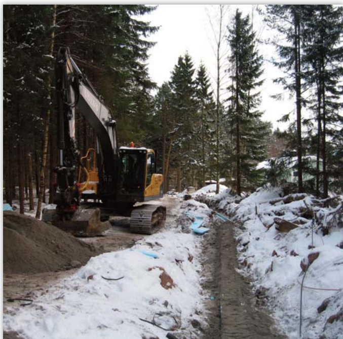
Arbetet med nya VA-ledningar längs Vänerkusten pågår.
