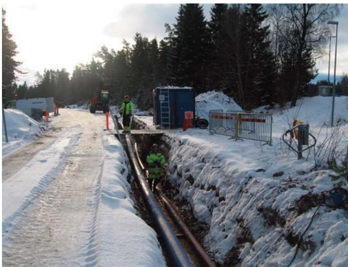
Arbetet med nya VA-ledningar längs Vänerkusten pågår.
